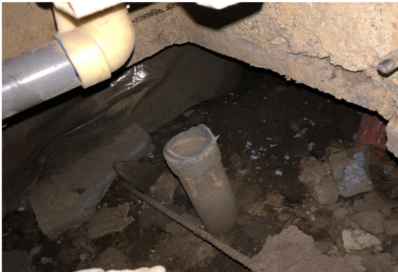
床下の配管周り
